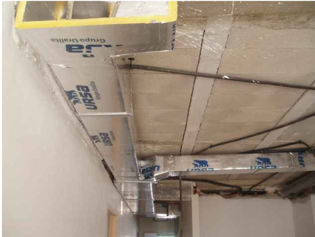
Sistema preinstalacion aire por conducto
